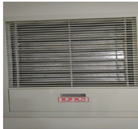
資料來源：林健富提供。 解說圖970-1：樓梯間火災排煙閘門設備
