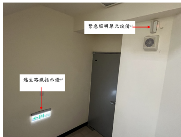
資料來源：林健富提供。 解說圖979-1：一般常見逃生用之照明設備
