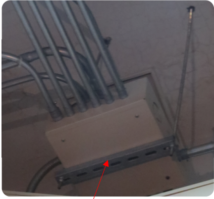
使用角鐵、螺栓、支架等配件加以固定於牆面
