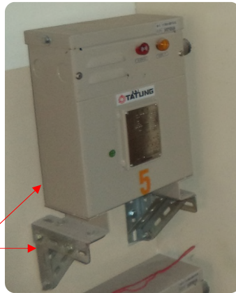
使用角鐵、螺栓、支架等配件加以固定於牆面
