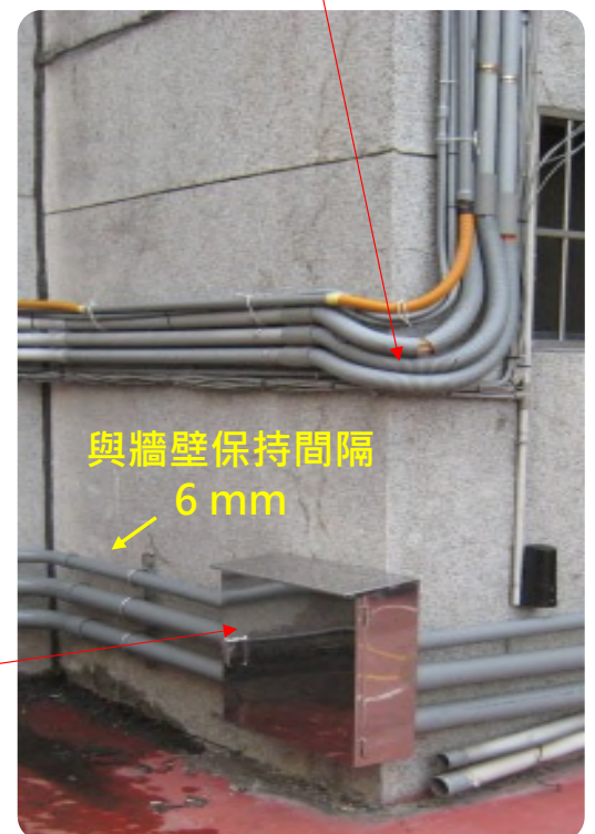
採不鏽鋼材 質允許不用 與牆壁保持 6 mm
