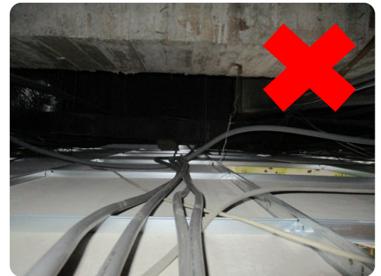
PVC電纜不得直接鋪設在天花板，天花板網格支撐力有限
