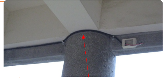
緊靠並沿建築物完成表面敷設
