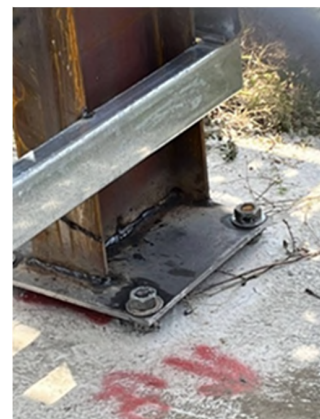
解說圖98-1：建築物之金屬構架作為接地電極
