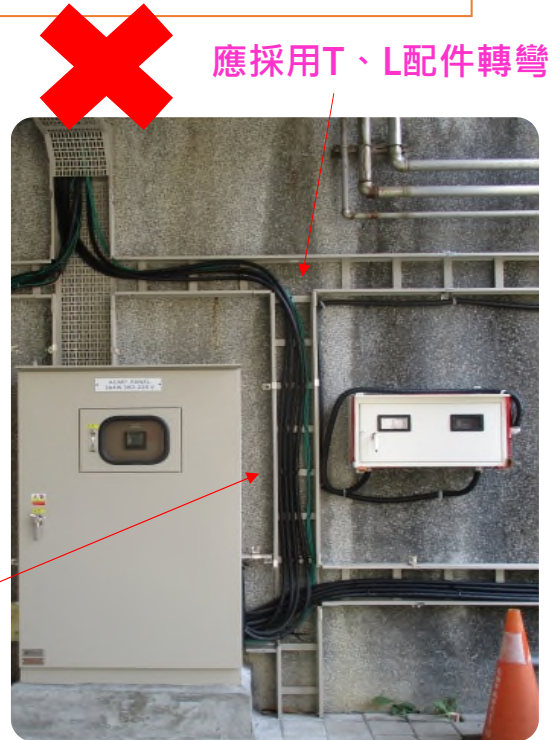
電纜垂直/傾斜 裝設 應確實固定於 電纜架橫桿
