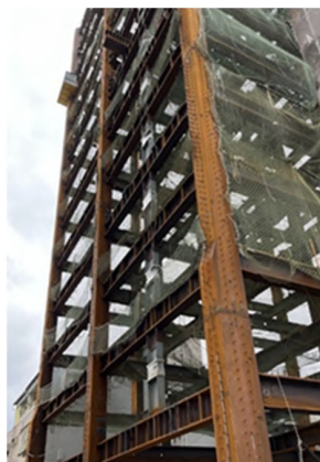
解說圖98-1：建築物之金屬構架作為接地電極
