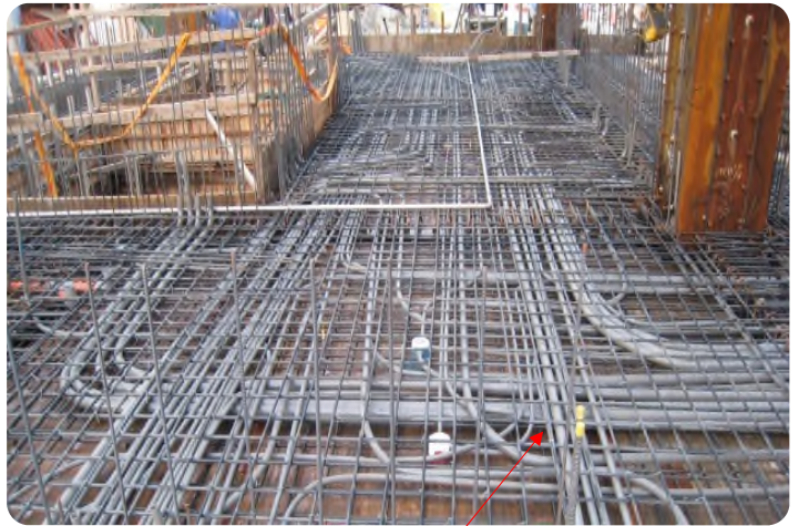
集中配置時 不得超過混凝土厚度1/3
