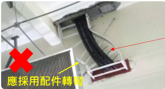
電纜垂直/傾斜 裝設 應確實固定於 電纜架橫桿
