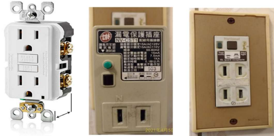
人員保護用之漏電啟斷裝置(GFCI)型插座
